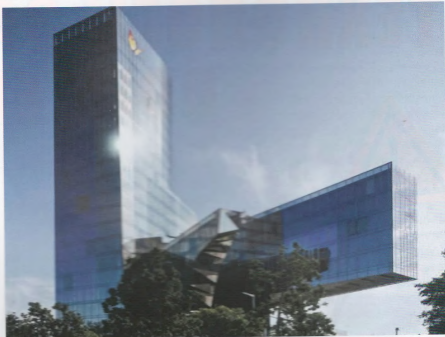
Рисунок 2 – Зовнішній вигляд будівлі «GasNatural» (м. Барселона).
